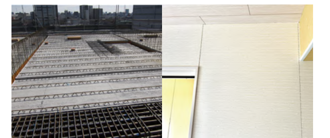
スラブPC施工例
