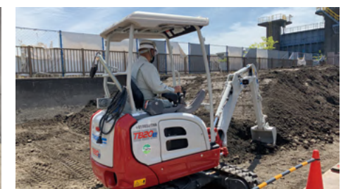
電動バックホーの採用 (試験採用)
